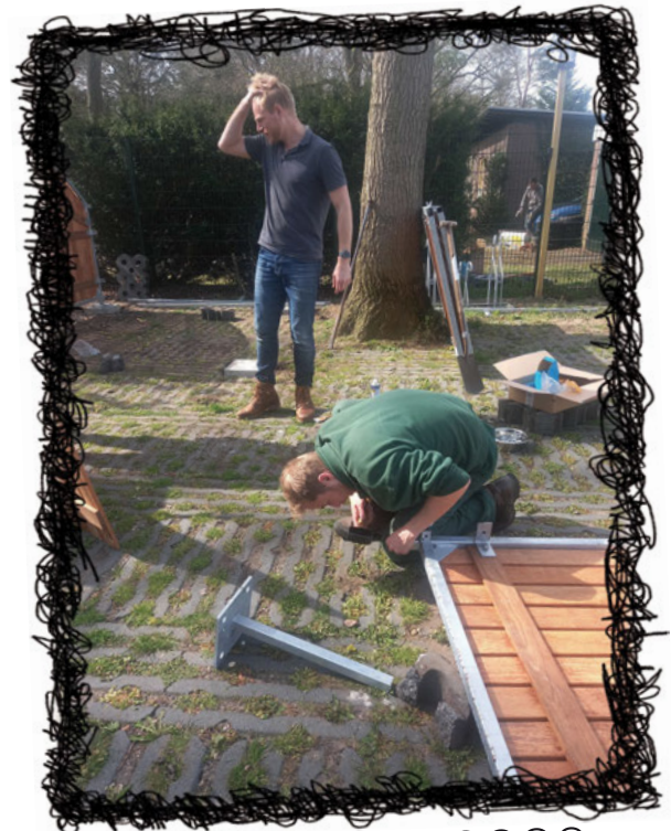
Bramen in de buizen bemoeilijken het werk. Met een vijl worden deze verwijderd.
